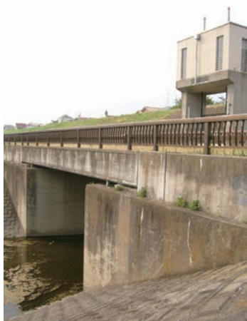
分流雨水放流渠 きよ (猪方排水樋門・駒井町 3 丁目)
