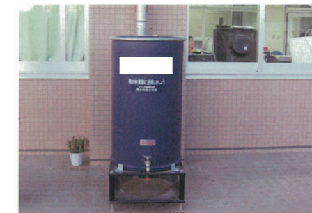
雨水貯留施設の例(水資源としての循環と利用)
