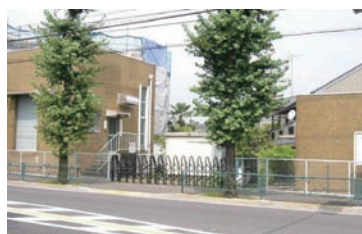
狛江(中継)ポンプ場（東和泉 1 丁目）
